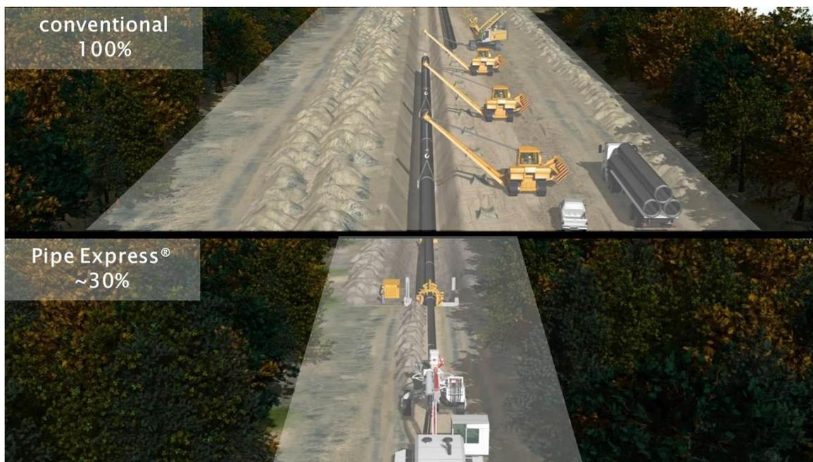
**FIGURE 3 PIPE EXPRESS<sup>®</sup> OPERATION IN NARROW PIPELINE CORRIDORS**
