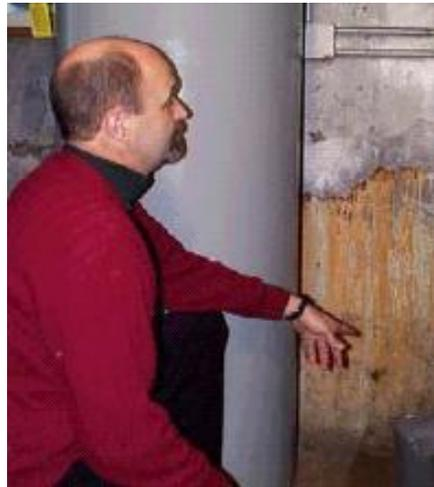
FIGURE 2 SEVERE WATER INTRUSION
